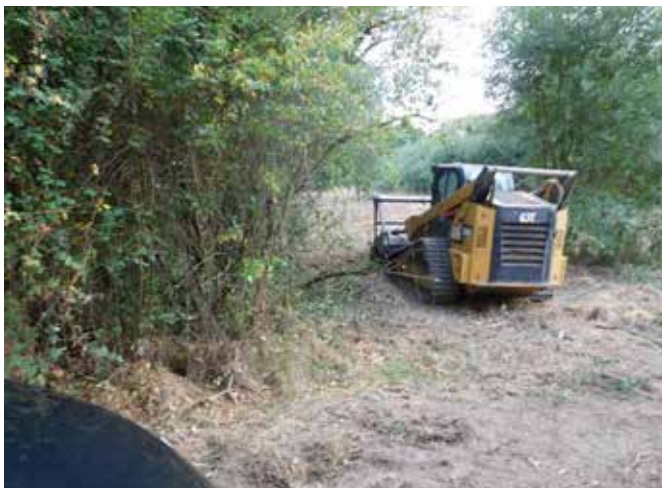
25/07/2022 Démarrage des travaux de débroussaillage
