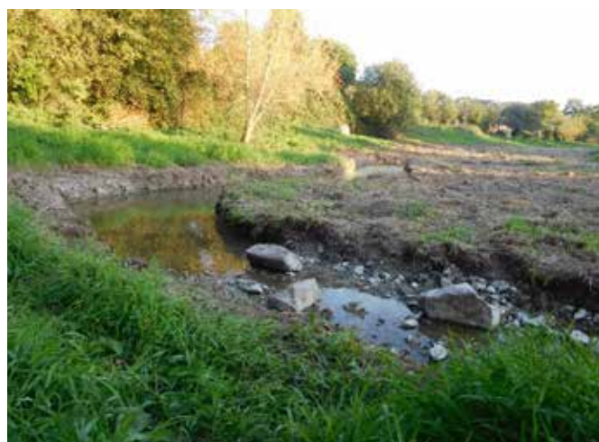
21/09/2022 Les terrassements pour le reméandrage
